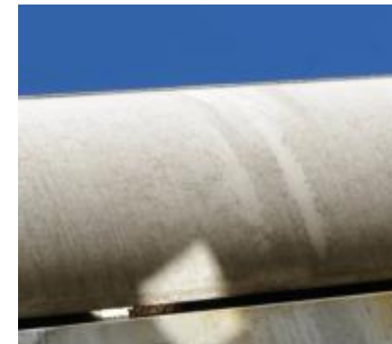
Corniche disjointe permettant le passage des chiroptères (source : LPO Rhône-Alpes)
