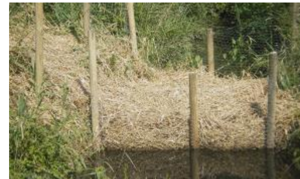
Système de filtration à paille (à gauche) et dispositif de tri sélectif sur un chantier (à droite, photo Naturalia)
